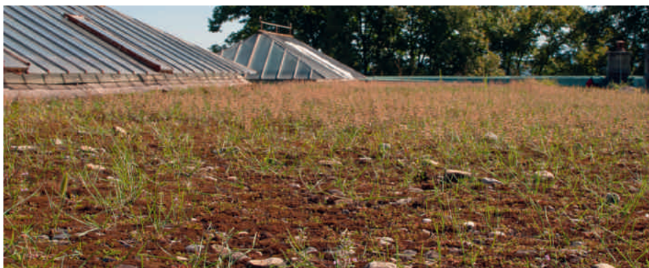
Toit de la Console des Conservatoire et Jardin botaniques. Toit sur gravier avec une végétation spontanée importante.
