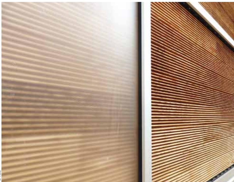
l'énergie solaire, explique l'architecte. Un vide d'air est réservé entre le vitrage de 4 mm d'épaisseur et une couche de laine de bois rainurée, de telle sorte que le soleil d'hiver puisse pénétrer et que la chaleur soit emmagasinée. Ce système a pour avantage d'augmenter la performance énergétique du bâtiment.» Un argument en faveur de «la responsabilité citoyenne» qu'il défend.
