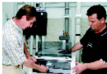
Une rénovation de la chauffage ne dure en général que quelques jours.
