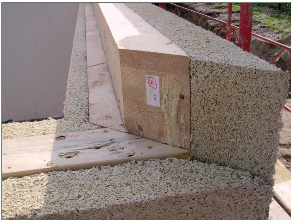
Détail d'assemblage, les murs en béton de chanvre sont préfabriqués puis mis en oeuvre.
