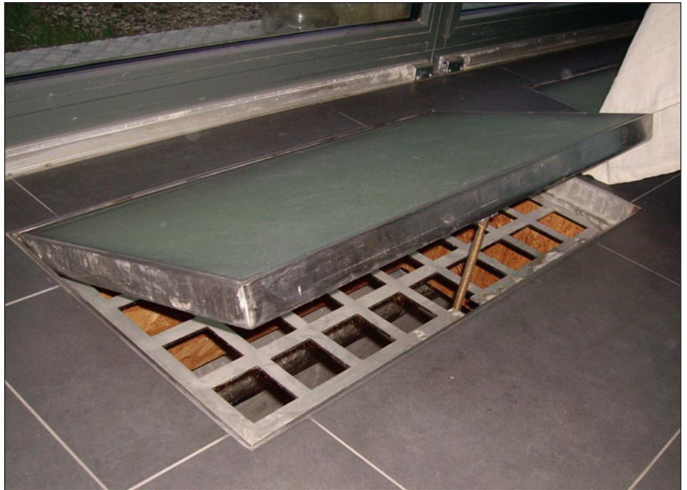
La trappe entrouverte permet de régler la circulation d'air dans le séjour.
