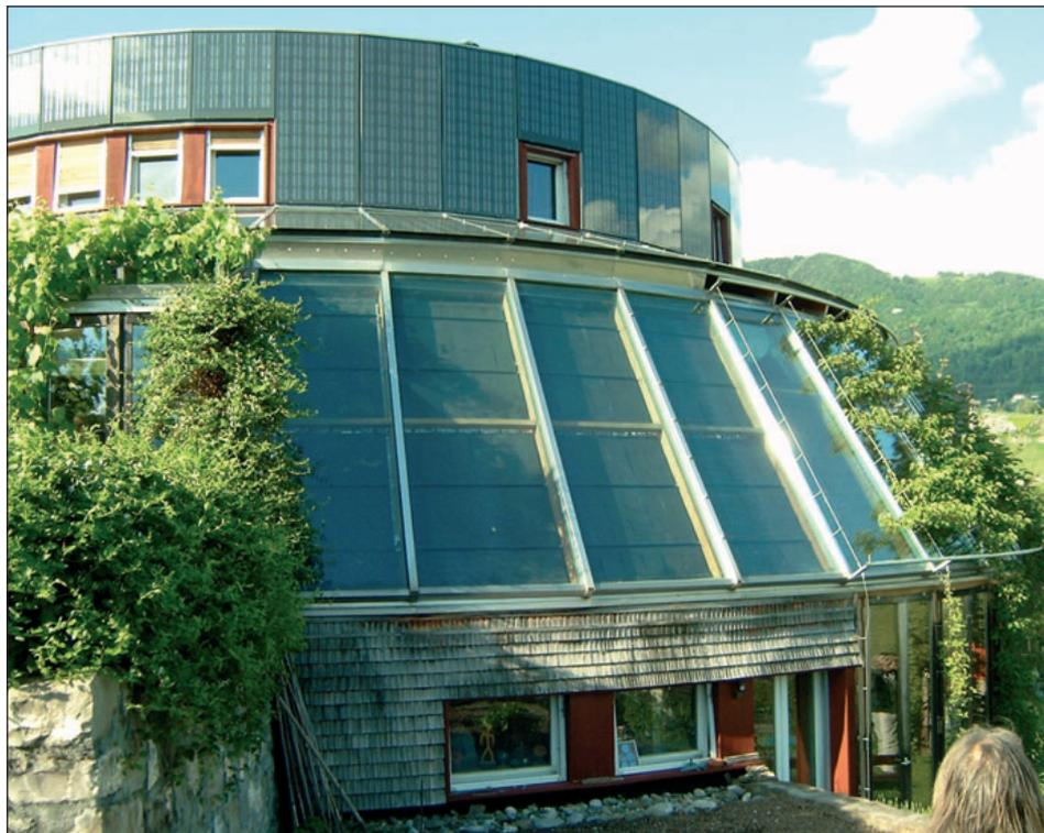
D'aspect insolite, la maison clef de sol sur les hauteurs de Vevey est équipée de panneaux solaires photovoltaïques dans sa partie supérieure et de capteurs solaires thermiques protégés à l'abri de la véranda.
