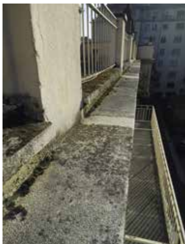
Les professionnels opèrent sur toutes les structures du bâtiment.
