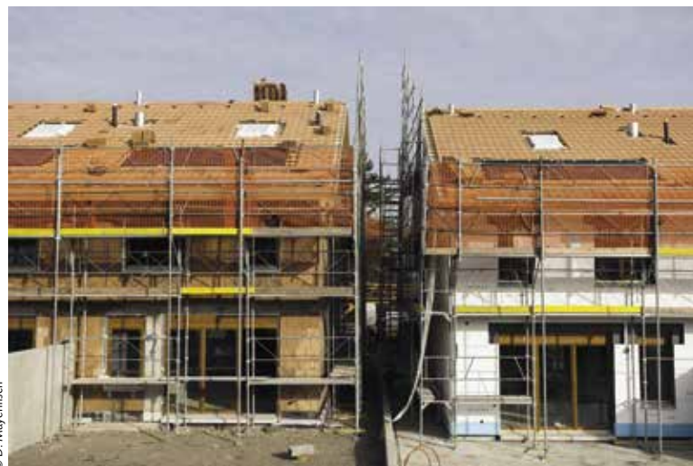
Isolation de façades sur des nouvelles constructions.
