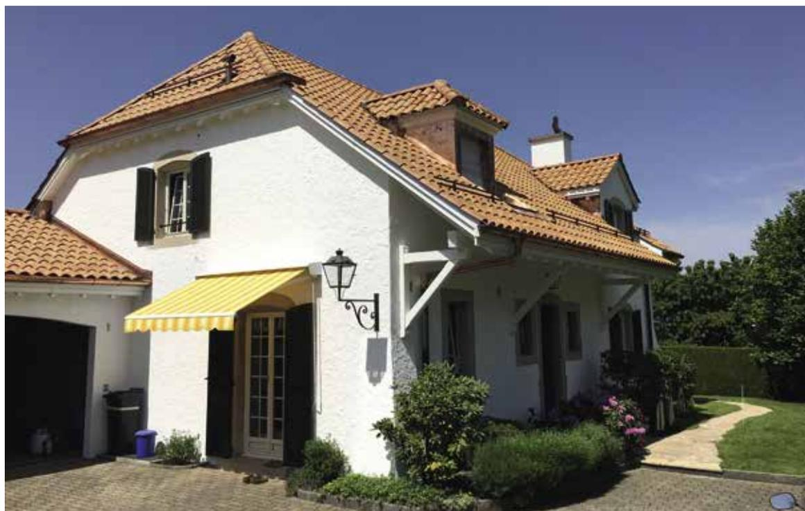
Toiture style provençal avec couverture en tuiles à emboîtement et ferblanterie en cuivre.
