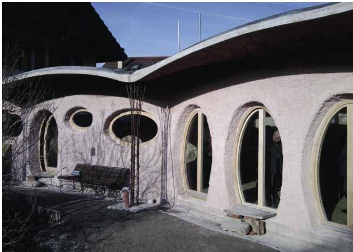
Exemple d'une maison ECO-BIO à Châtel-Saint-Denis réalisée par le constructeur Pittet-Artisan. Les murs sont en chaux-chanvre projeté et la toiture végétalisée est constituée par une voûte sarrasine réalisée en briques de terre cuite recouverte d'une isolation en chanvre. Un petit poêle à bois suffit à chauffer tout l'espace intérieur.
