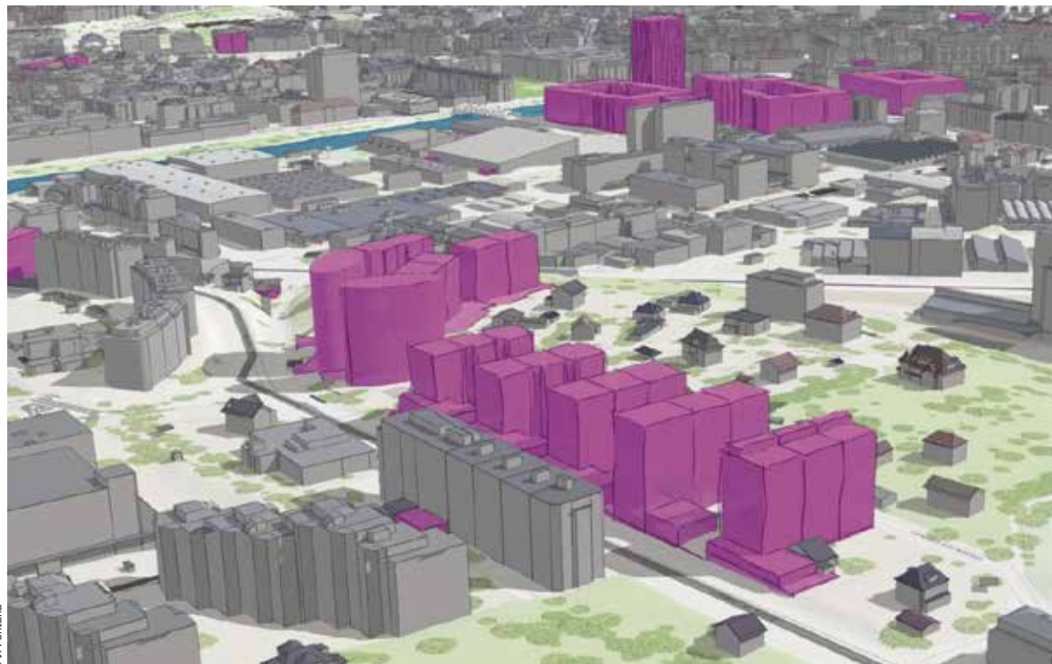
Le futur quartier de Surville (Lancy) au premier plan avec, au second plan, les futures constructions aux Vernets
