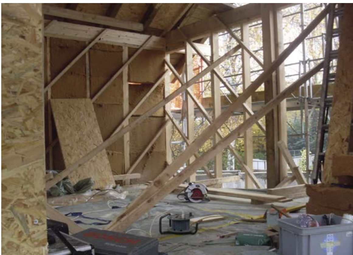
Construction en ossature bois avec isolation en laine de bois (Eco-logique Sàrl)
