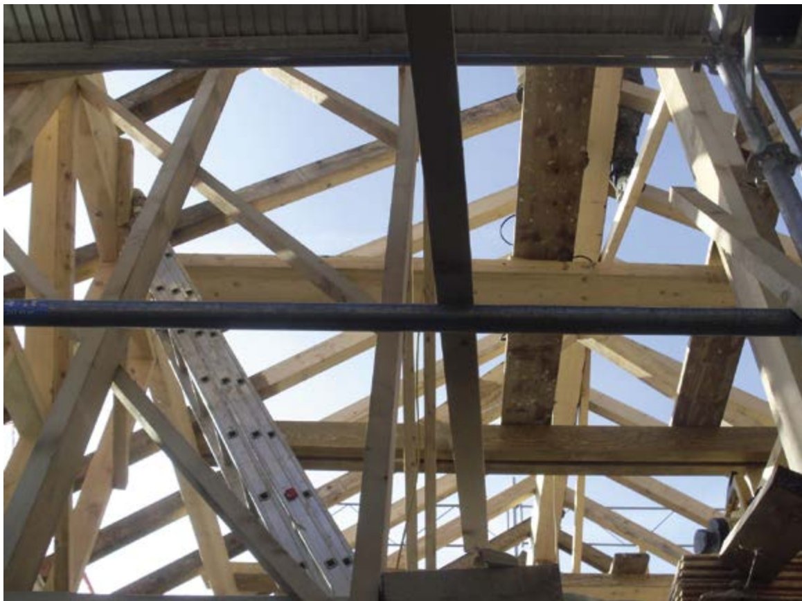
Construction en ossature bois avec isolation en laine de bois (Eco-logique Sàrl)
