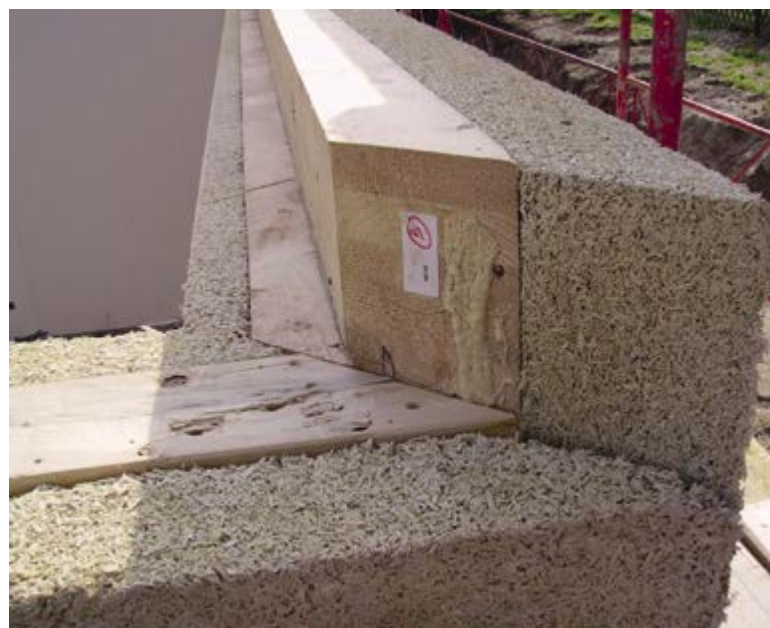
Construction en ossature bois et chanvre coulé (Eco-logique Saràl)
