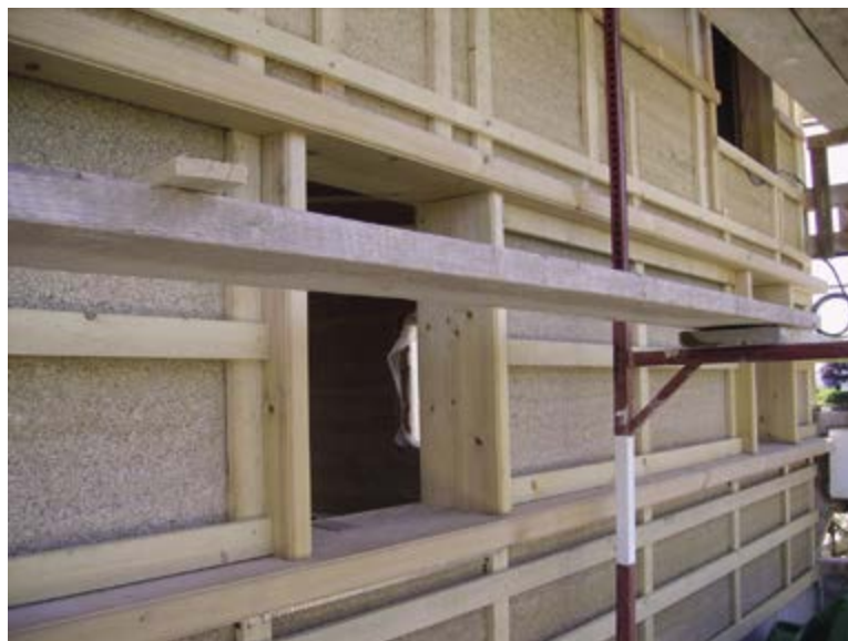
Construction en chanvre banché et bardage bois (Eco-logique Sàrl)
