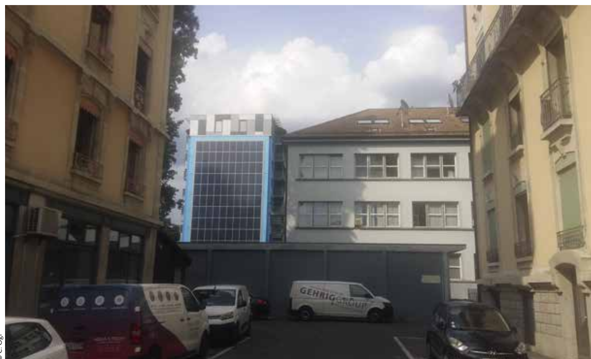
La façade solaire au 9 Chemin des Maraîchers
