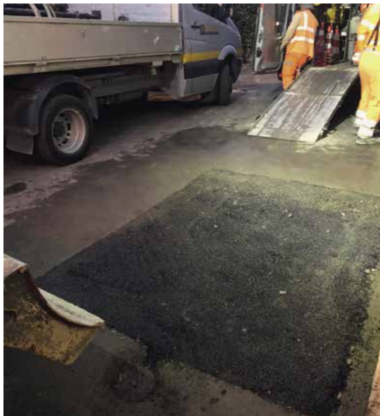
Fin de l'intervention, le trou est rebouché et l'asphalte posée.
