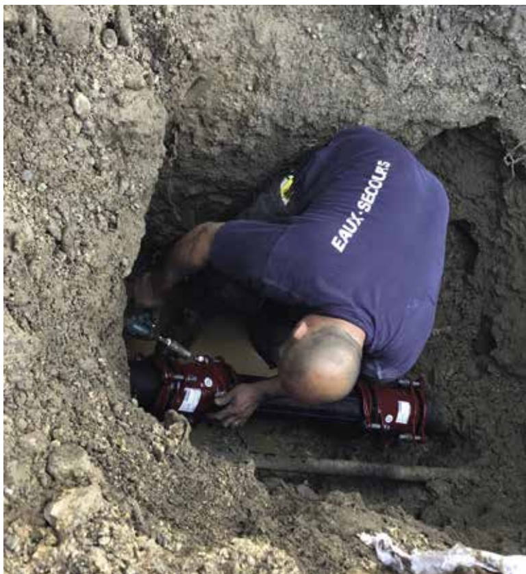
Remplacement de la conduite d'eau.
