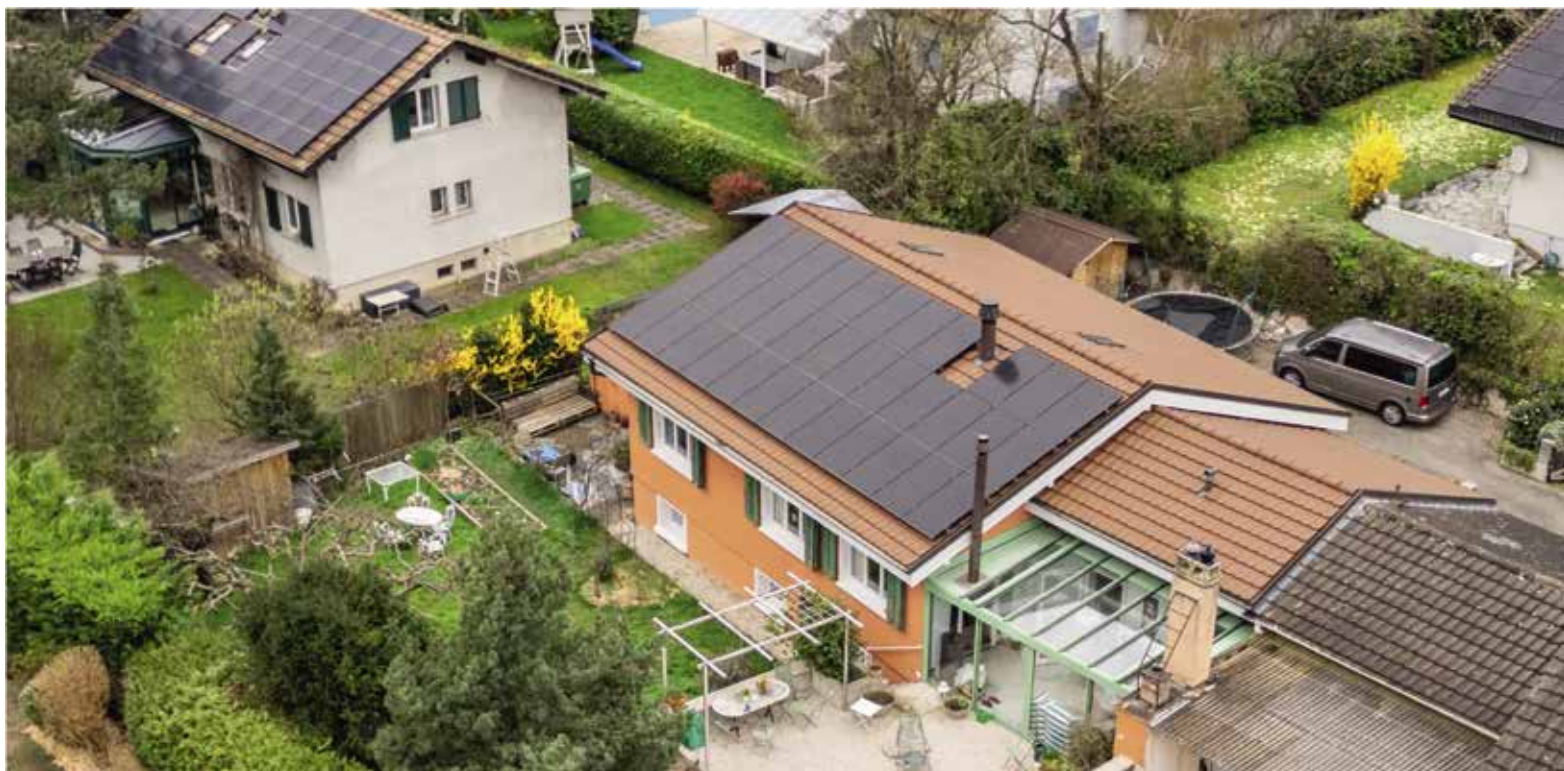
Association d'une pompe à chaleur et d'une centrale solaire pour maximiser l'autoconsommation.
